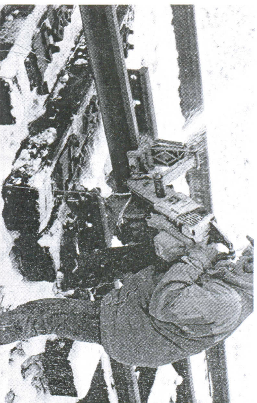
Bis zum Härtsfeldsee wird zurzeit die Trasse der „Schättere“ verlängert. Die Mitglieder des Museumsbahnvereins verlegen dafür die Gleise. Dietmar Fischer sägt die Schiene auf die richtige Länge (rechts).
