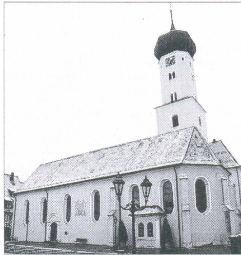
Erhebliche bauliche Mängel verdecken sich hinter den schneebedeckten Dachziegeln der katholischen Stadtpfarrkirche in Neresheim. Die Sanierung kostet mindestens 567 000 Euro. Foto: kdk
