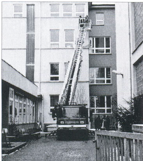
Eugen-Gaus-Realschule: In luftiger Höhe untersuchen Spezialisten Schäden am Außenputz. Foto: matze
