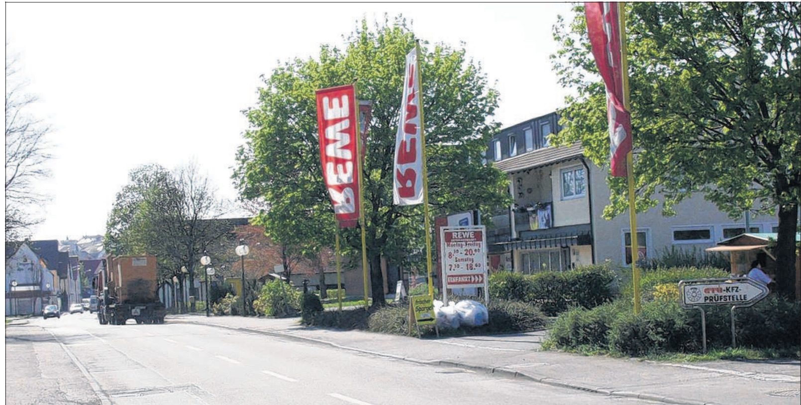
Die Brenzer Straße zwischen der Schiller- und der Goethestraße in Sontheim/Brenz wird breiter: Sie bekommt eine Linksabbiegespur für alle Kunden, die zum großen Rewe-Markt wollen. Die Bauarbeiten für den Supermarkt beginnen in wenigen Tagen.
