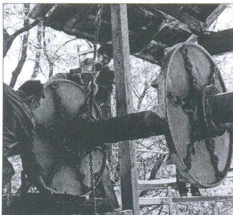
Diverse Handgriffe waren notwendig, bis das schwere Eisenteil aus den Angeln gehoben werden konnte. Obwohl 90 Jahre nicht gelaufen, ist die Welle in erstaunlich gutem Zustand.
