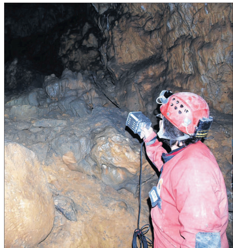
Oliver Heil von der Beleuchtungs-Fachfirma leuchtet die Höhlenwände und -hallen aus. Rund 300 neue Lampen werden installiert.
