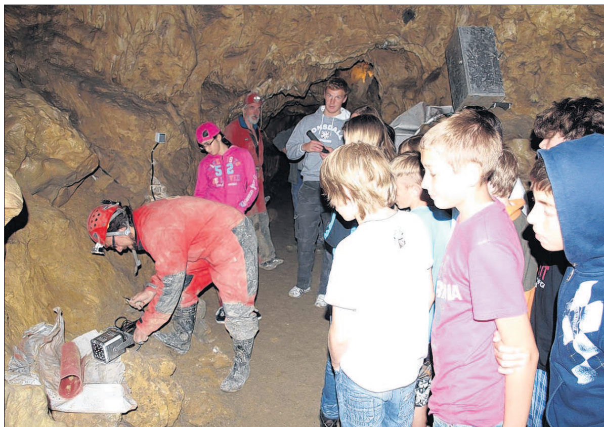
Obwohl die Installationsarbeiten für die neue Beleuchtung laufen, finden in der Charlottenhöhle Führungen statt. Derzeit kann der Besucher zwischen dem alten und dem neuen Licht vergleichen.
