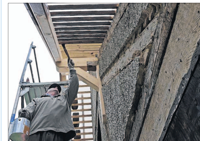
Immer wieder samstags: Freiwillige helfen bei der Sanierung der alten Feilenschleiferei in Königsbronn. Hier zum Beispiel pinselt Ex-Gemeinderat Thomas Kübler den neu gezimmerten Dachüberstand mit Wetterschutzfarbe ein.
