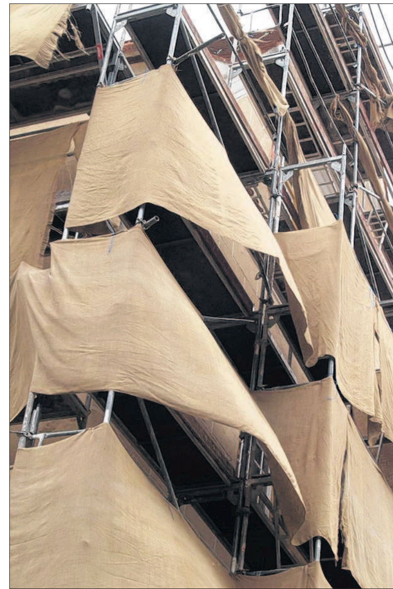
DER WIND BLÄHT DIE SEGEL in der Takelage und es ist doch nicht die Gorch Fock, die in Brenz festgemacht hat. Das Bild zeigt das Gerüst am Brenzer Schloss, das verhängt wurde, damit die Arbeit der Restauratoren gleichmäßiger austrocknen kann.
