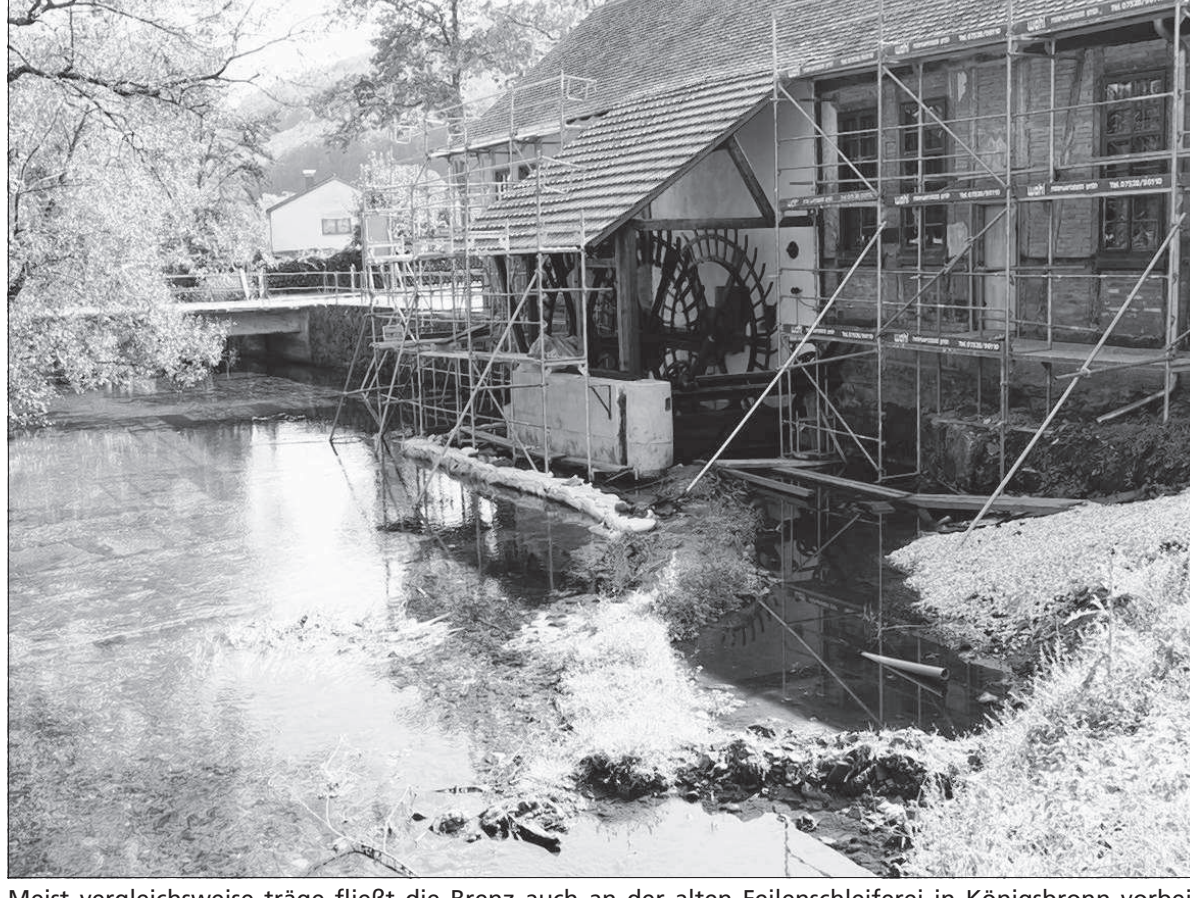
Meist vergleichsweise träge fließt die Brenz auch an der alten Feilenschleiferei in Königsbronn vorbei. Um das Wasserrad überhaupt antreiben zu können, braucht's ein Wehr, mit dem das Brenzwasser aufgestaut und die notwendige Fallhöhe erzeugt wird. Die damit verbundenen Eingriffe ins Ökosystem Brenz sollen ausgeglichen werden, unter anderem mit einer hier extra angelegten „Fischtreppe“.
