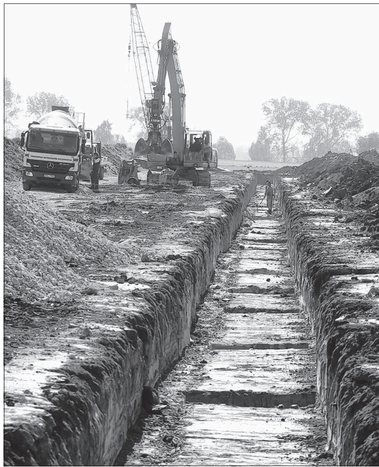
Im Zusammenhang mit der Sanierung der Brunnen im Donauried südlich von Niederstotzingen lässt die Landeswasserversorgung auch die Anschlussleitung zum Förderwerk erneuern. Foto: rv
